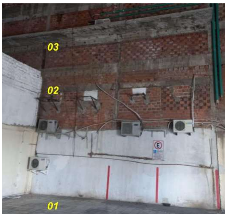
Figura 7: Demolições: 1- piso da Garagem Coberta; 2- trecho da viga de amarração do primeiro pavimento; 3- trecho da viga de amarração e passarela de manutenção do segundo pavimento
